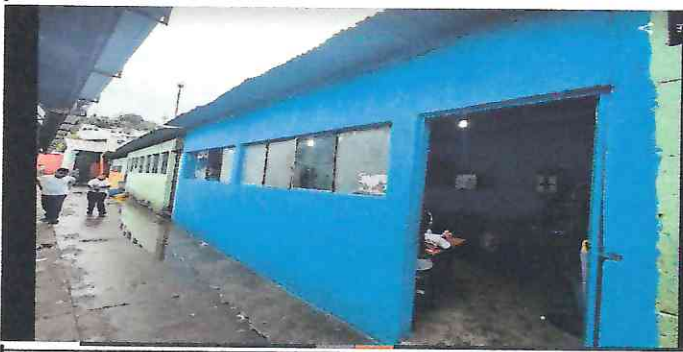
Foto 3: Sustitución de lamina
