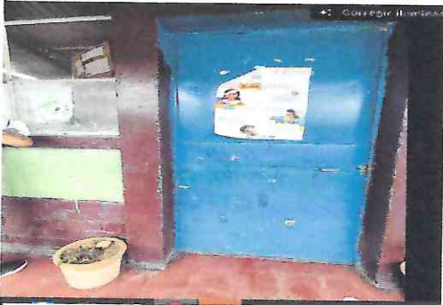
Foto 5: sustitución de chapa
