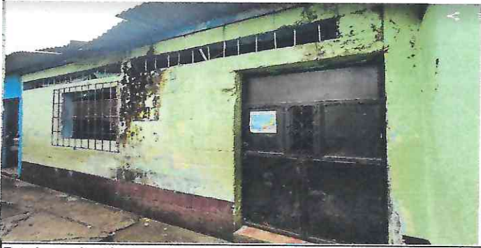
Foto 1: sustitución de lamina
