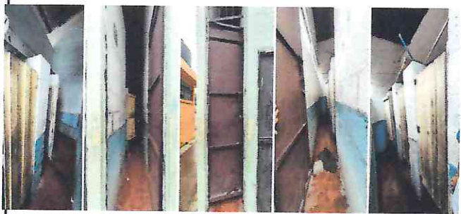
Foto 4: Sustitución de puertas, piso y pintura
