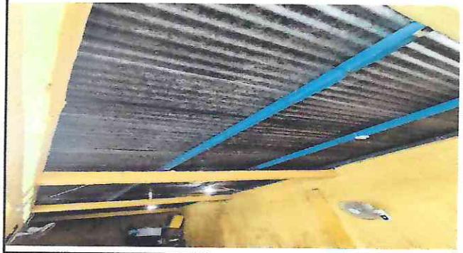
Foto 2: Sustitución de lamina
